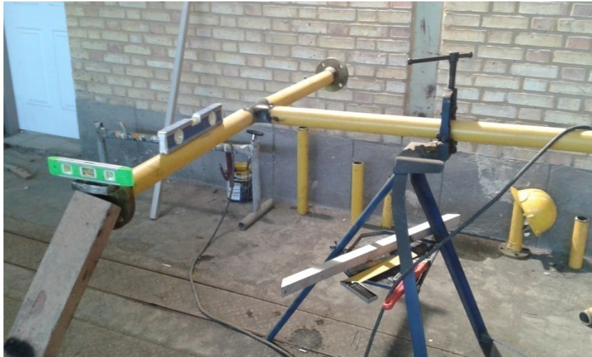
شکل ۴-۱: ساخت اسپول برای پلان شیرها (۱)
