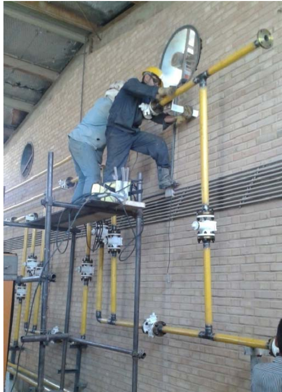
شکل ۳-۴: نصب اسپول‌ها روی دیوار برای تکمیل پلان شیرها
