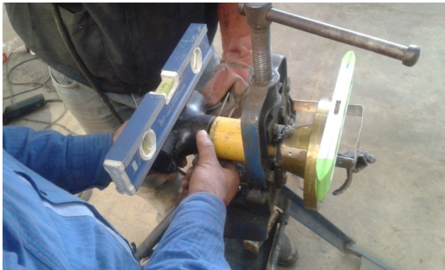
شکل ۴-۲: ساخت اسپول برای پلان شیرها (۲)
