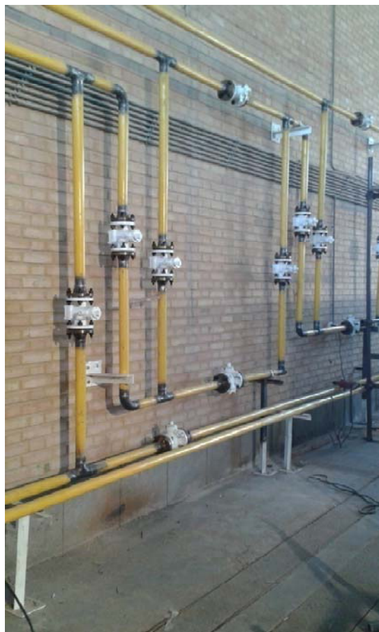
شکل ۴-۵: پلان شیرهای در حال تکمیل با استفاده از وصل کردن اسپول‌ها به هم (۲)
