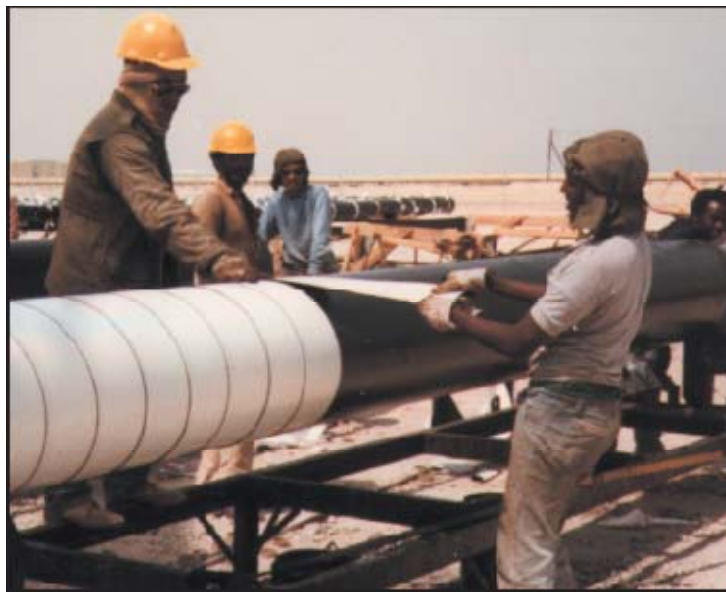
شکل ۷-۱۴: نحوه نوارپیچی خطوط لوله گاز با دست [۳]
