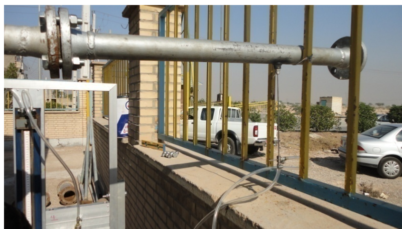
شکل ۲-۵۲: نصب دبی سنج و لوله‌ی رابط بر روی خط اصلی
