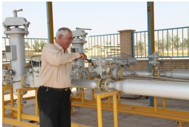
شکل ۲-۱۳: تنظیم فشار خط اصلی
