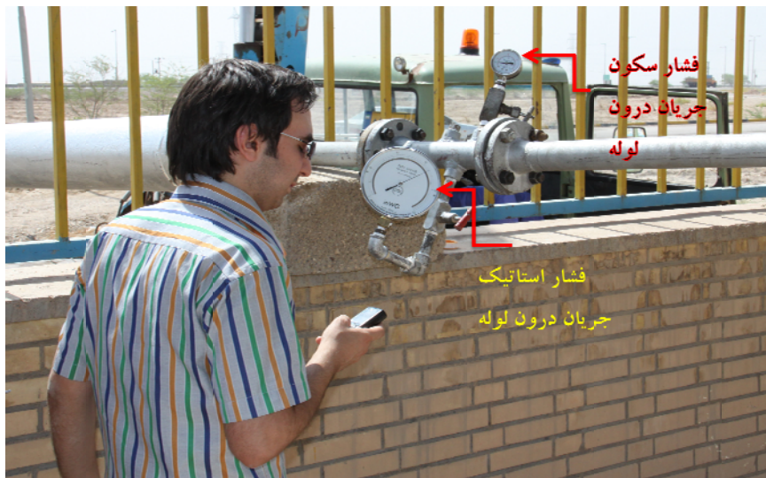
شکل ۲-۱۵: فشارسنج اندازه‌گیری فشار سکون جریان در لوله
