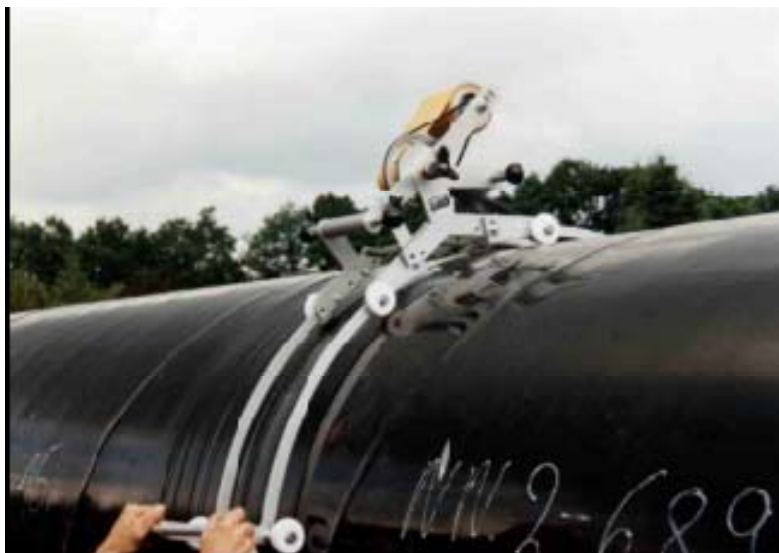
شکل ۷-۱۶: ماشین نواریچی دستی سایز بزرگ با بازوی کششی [۱]
