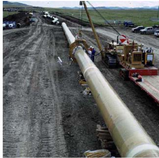
شکل ۷-۱۸: ماشین نواریپیچی با موتور [۴]
