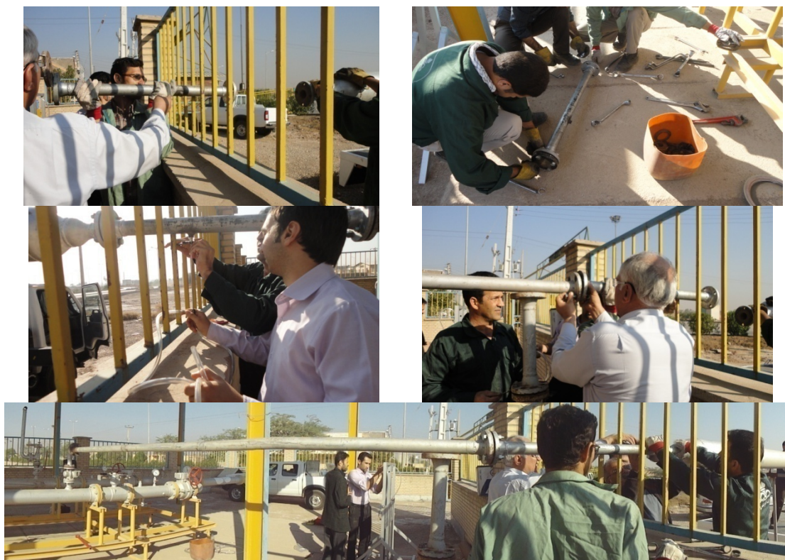
شکل ۲-۵۰: مراحل مختلف نصب تجهیزات بر روی خط اصلی
