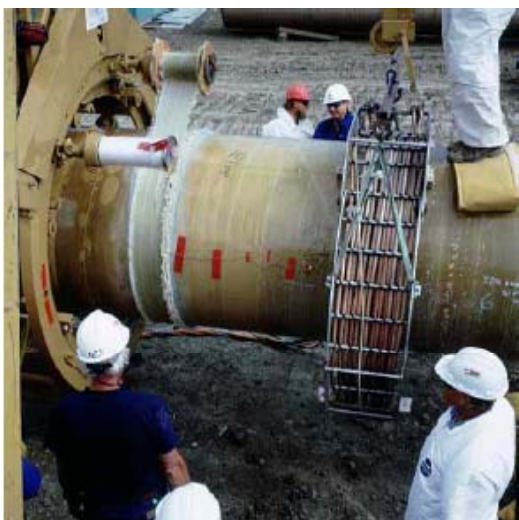
شکل ۷-۱۹: نحوه کار ماشین نواریپیچی با موتور [۴]
