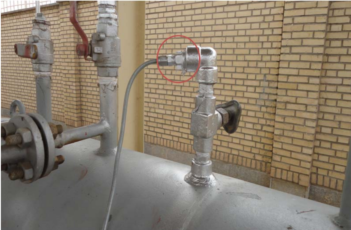
شکل ۷-۲۷: شیر یک طرفه استفاده شده در طرح
