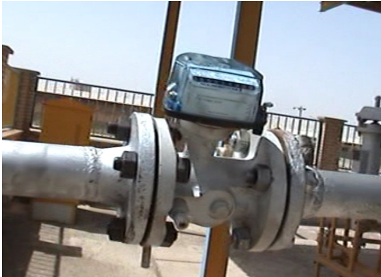
شکل ۲-۲: دبی‌سنج نصب‌شده بر انشعاب ۲ اینچی جهت قرائت دبی هدر رفت
