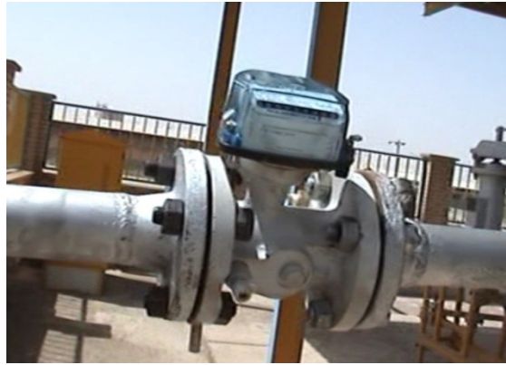
شکل ۲-۵: دبی سنج قدیمی (سمت راست) و جدید (سمت چپ) نصب شده در محل تست
