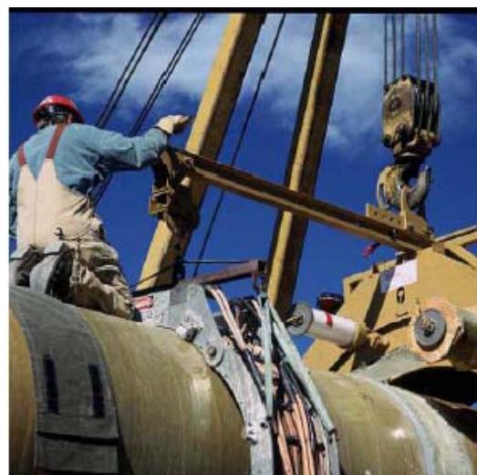
شکل ۷-۱۹: نحوه کار ماشین نواریپیچی با موتور [۴]
