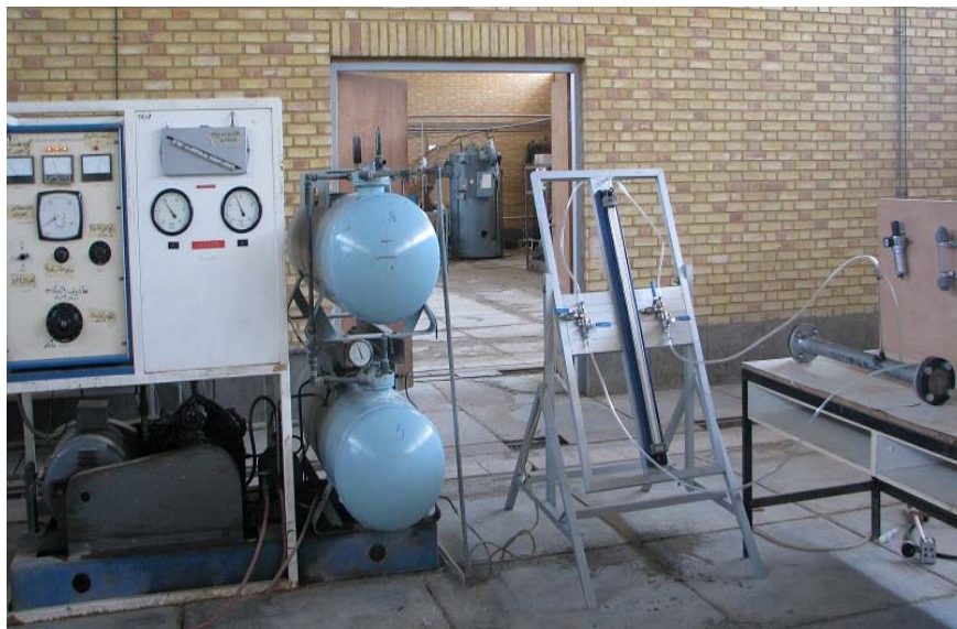
شکل ۲-۴۷: نمای کلی از تست نشتی دبی سنج
